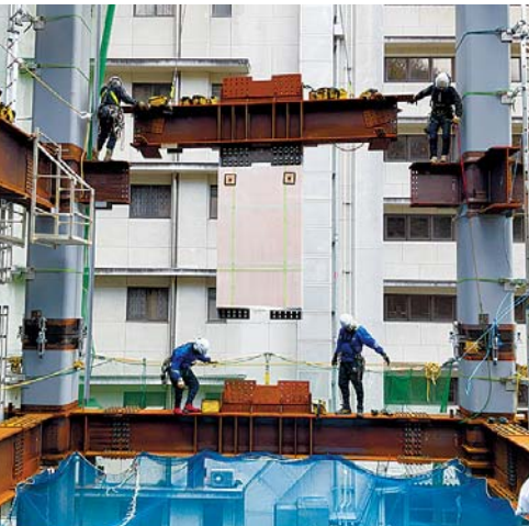
地組みしたCLT耐震壁の取り付け
