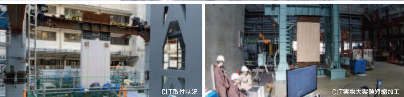
CLT取付状況
