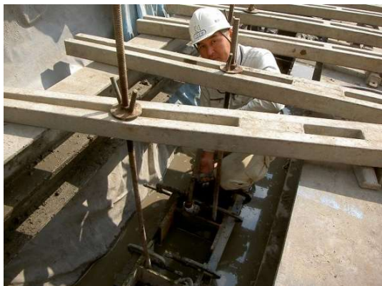
H 鋼建込み後
