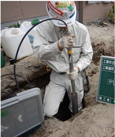
挿入式傾斜計 測定状況例
