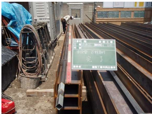
傾斜計測定管（上端）
