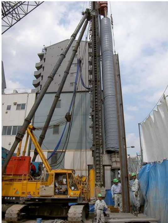
H 鋼建込み
